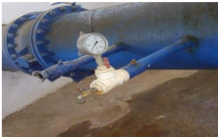
**Figure 9 : Point de prélèvement de l'eau brute**
