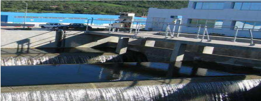
**Figure 07 : Ouvrage d'entre et d'aération**
