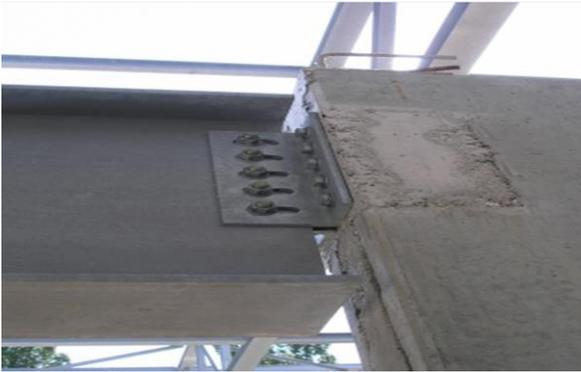
Figure 64: Assemblage poteau en béton armé et poutre métallique
