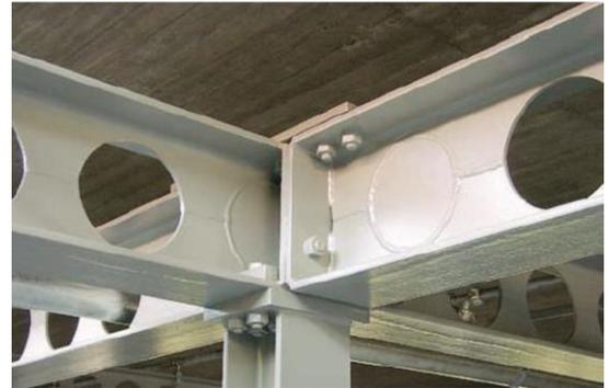
Figure 65: Assemblage poteau-poutre métallique
