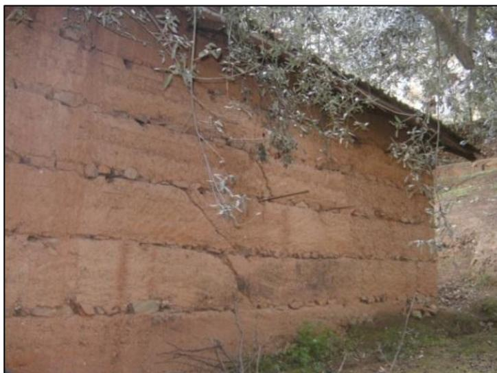
Figure 55 : mur en pisé sans enduit (S.Salmi.Ait Itchir, nov2010)
