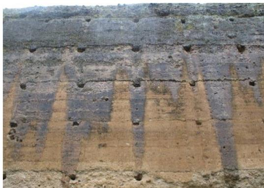
Figure 35 : un mur en pisé durant une averse de pluie (Jaquin, 2008)
