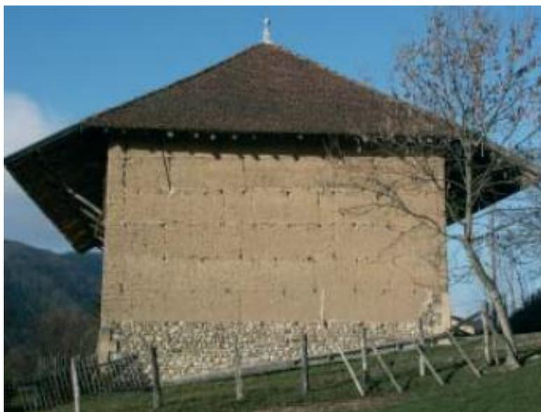
Figure 20 : une maison en pisé au nord Isère montrant le soubassement en maçonnerie et la toiture débordante (CRATerre)
