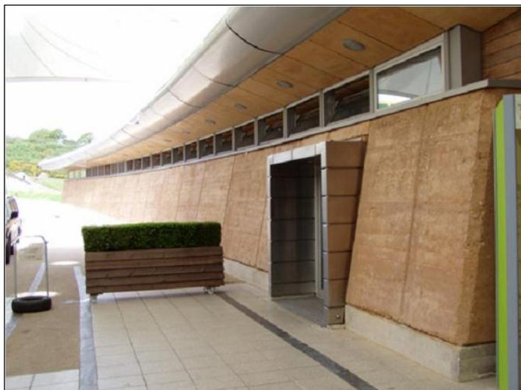
Figure 36 : Bâtiment en pisé stabilisé au ciment (Maniatidis, 2003)
