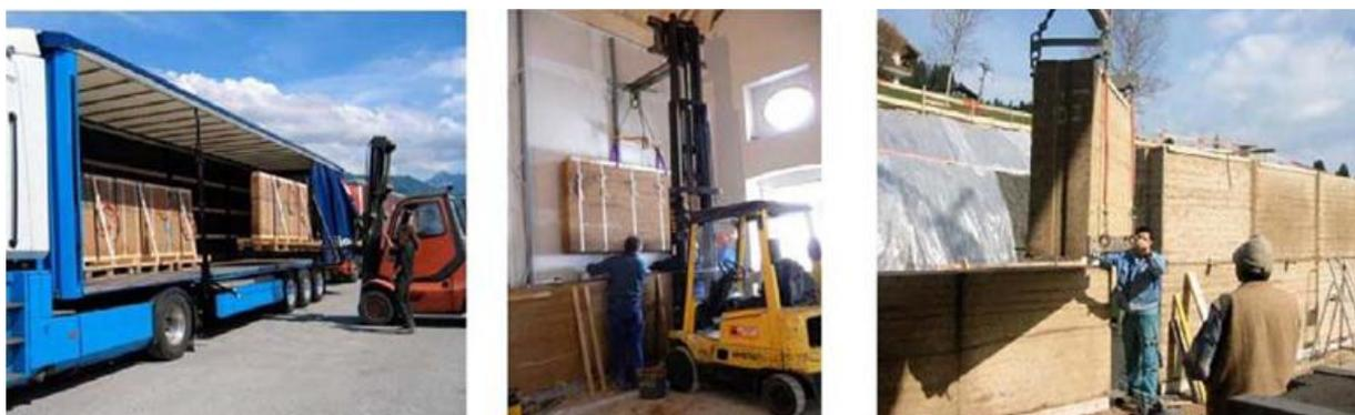
Figure 29 : Transport et mise en œuvre des éléments préfabriqués (Rauch, 2007)
