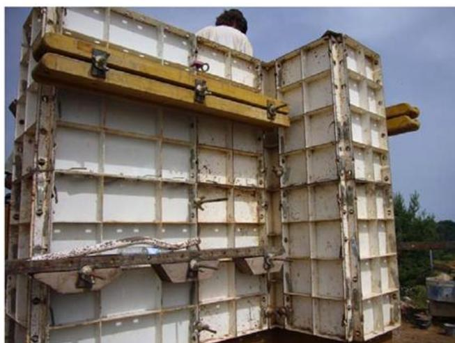
Figure 27 : Coffrage métallique du pisé moderne sur un chantier en France. Photo : N. Meunier (Bui.Q.B, 2008)
