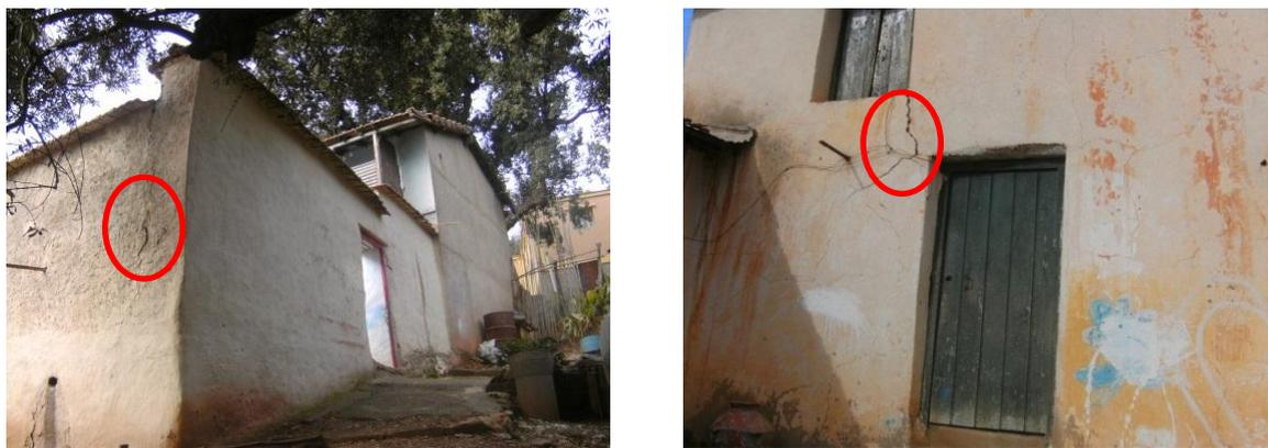
Figure 64: fissures au niveau des angles et des baies (S.Salmi.Ait Itchir Nov 2012)
