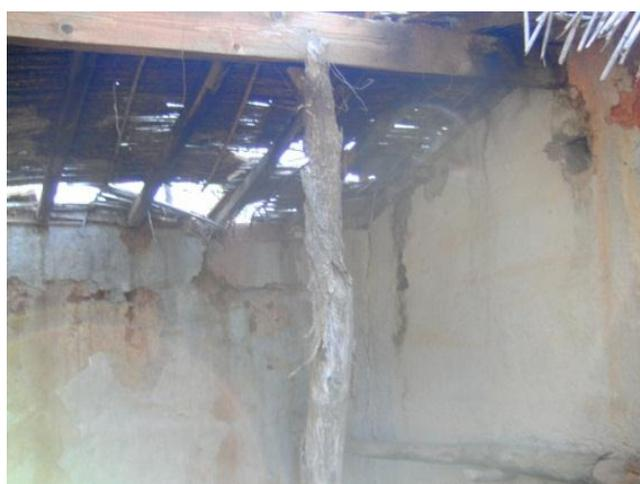
Figure 66: décomposition du matériau et effondrement (S.Salmi. Ait Itchir. Nov 2012)
