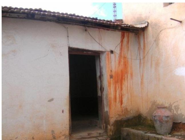
Figure 65: taches d'humidité sur les murs(S.Salmi.Ait Itchir.Nov 2012)
