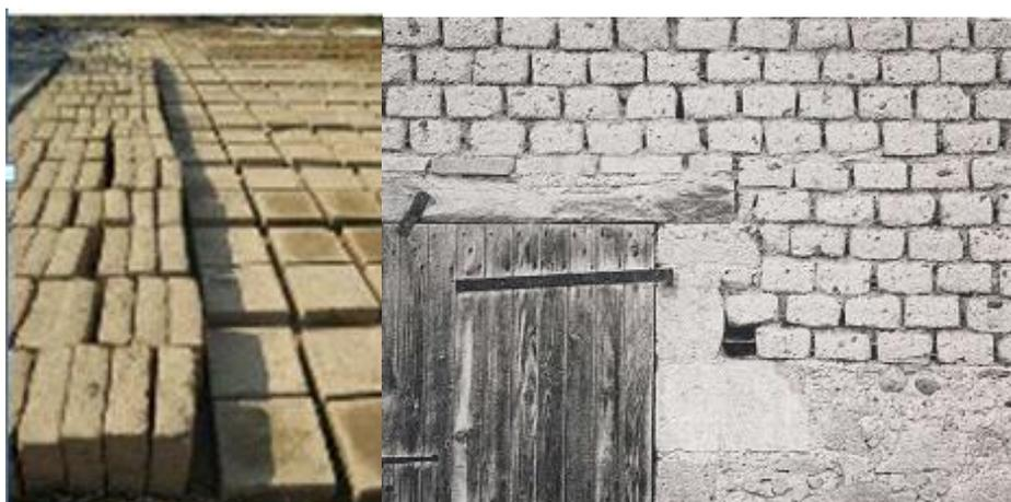
Figure 7 : A gauche : des adobes au séchage sous le soleil. A droite : une maçonnerie en adobes.
