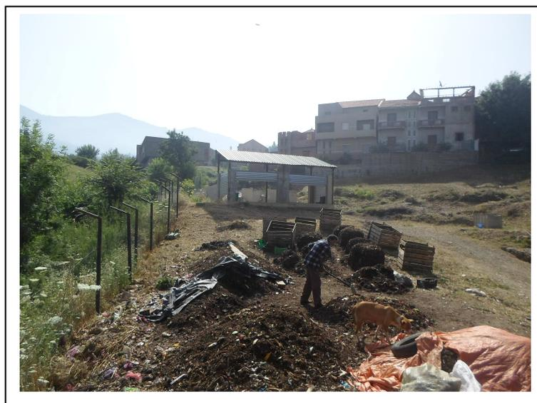
**Figure 16 :** Compostage en tas au lieu du compostage dans des composteurs.
